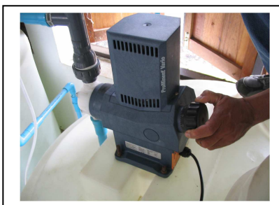
รูปที่ 54 การปรับอัตราการจ่ายสารละลายคลอรีนที่ประมาณ 80%
