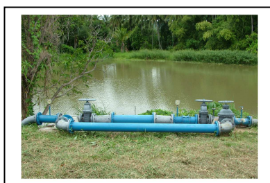
รูปที่ 38 ท่อกวน (Inline Static mixer)
