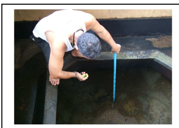
รูปที่ 46 การปรับอัตราปริมาณน้ำล้างย้อนเพื่อใช้ในการล้างหน้าทรายกรอง
