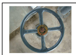
รูปที่ 71 เปิดประตูน้ำล้างทิ้ง (ประตูน้ำหมายเลข 5)
