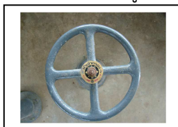
รูปที่ 69 ปิดประตูน้ำเข้ากรอง (ประตูน้ำหมายเลข 9)
