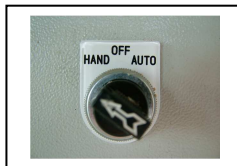
รูปที่ 25 สวิตช์ลูกศรที่ตำแหน่ง “HAND”
