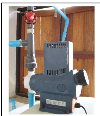
รูปที่ 53 รายละเอียดของเครื่องจ่ายสารละลายคลอรีน
