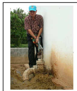
รูปที่ 85 เปิดประตูน้ำระบายตะกอน ข้างถังรวมตะกอน (ประตูน้ำหมายเลข 8)
