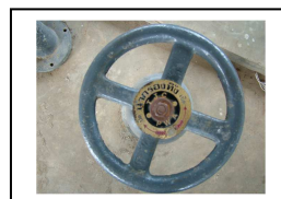
รูปที่ 65 เปิดประตูน้ำกรองทิ้ง (ประตูน้ำหมายเลข 4)
