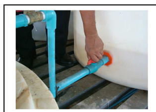
(5) เปิดสารละลายสารส้มลงถังจ่ายสารละลายสารส้ม
