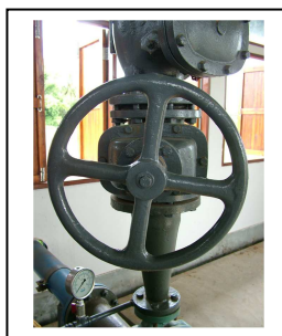
รูปที่ 79 ปิดประตูน้ำที่ช่องทางส่งของเครื่องสูบน้ำดี
